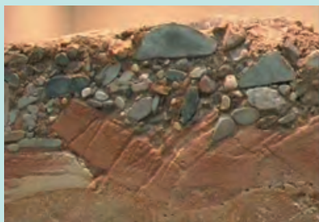
Querschnitt durch eine römische Straße
