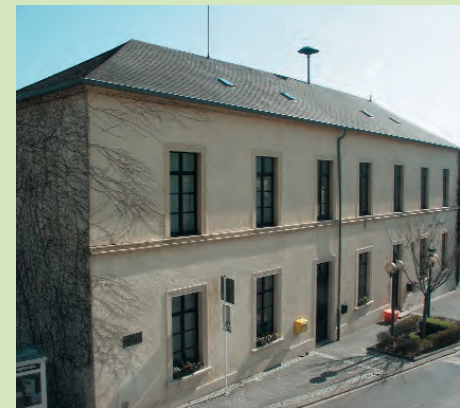
Die alte Schule, die später auch die Post und die Gemeindeverwaltung beherbergte - heute Vereinssaal und Sitz einer Bankfiliale. Im Obergeschoss sind das "Syndicat d'Initiative" und die "Geschichtsfrënn" untergebracht.
