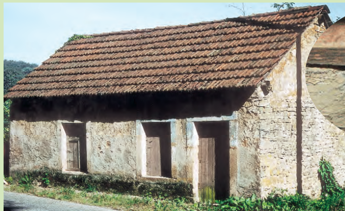
Die Strohwicklung zwischen den Dachbalken
