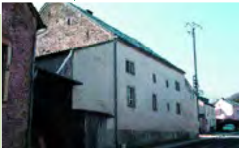
Zammeschmühle Die 1797 als Mehlmühle von Michel Weydert gegründete "Zammeschmühle" hat ihren Namen von der Familie Zimmer, die bis zum Jahr 1729 das Anwesen Zammesch bewohnte. 1811 wurde die Mühle zur Papierfabrik umgebaut, die bis in die zweite Hälfte des 19. Jahrhunderts in Betrieb war. Danach diente sie, bis zur Einstellung des Mühlenbetriebs in den 30er Jahren des letzten Jahrhunderts, wieder zum Mahlen von Getreide.
